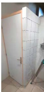
Sécurisation du cumulus de la Salle des fêtes
