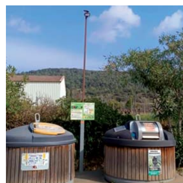
Mise en place d'un mât solaire au point de tri du Monument aux morts
