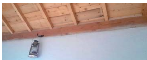
Fermeture du bas du toit de la gare
