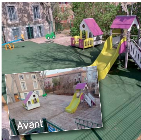
Installation de plaques amortissantes aux jeux du Boulodrome
