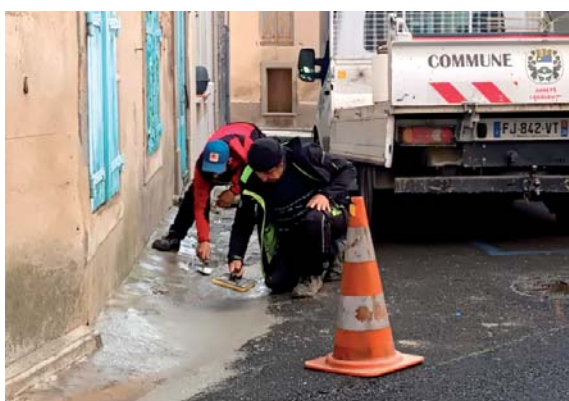
Restauration de caniveaux
