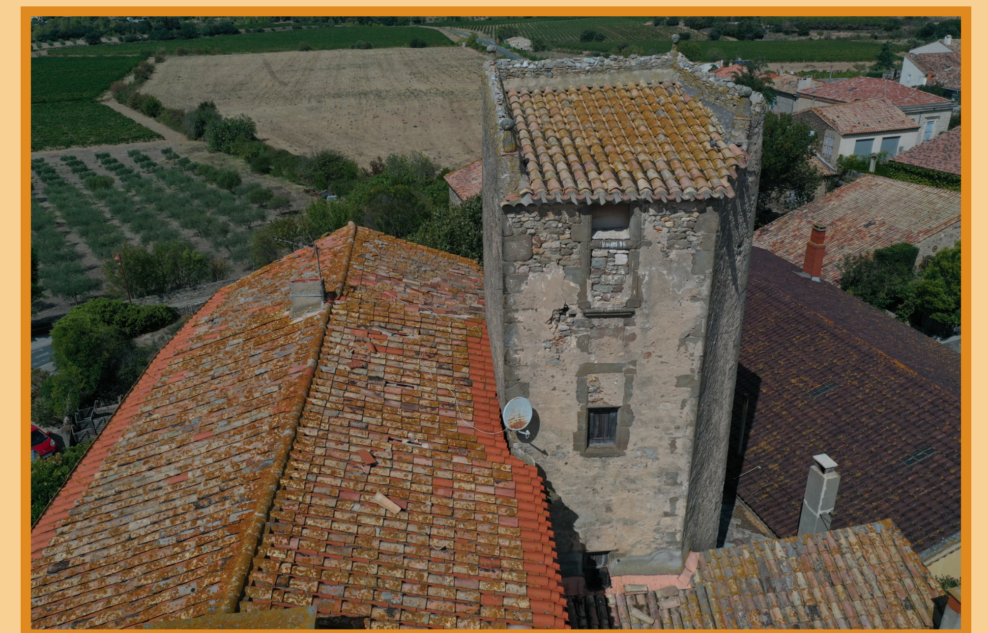
FAÇADE EST ET TOUR D'ESCALIER
